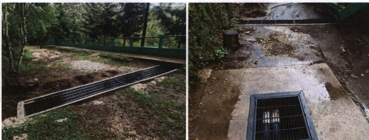
Foto 26-27: Zanja y pozo de absorción para conservación de suelo y manejo de agua pluvial en el mirador principal y granja educativa
